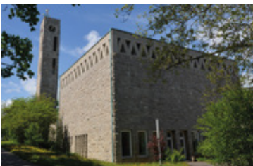
Christuskirche Maibacher Str. 50 97424 Schweinfurt
